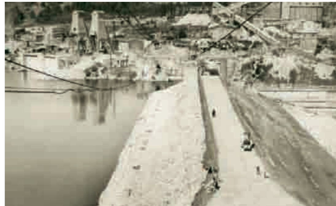
Hráz hlavní vodní nádrže Lipno I je z jedné třetiny betonová, zbytek tělesa je sypaný. Délka hráze dosahuje bezmála 300 metrů a nad terénem se vypíná do výšky 28 metrů. Aby dokázala odolávat tlaku více než 309 milionů krychlových metrů vody, je přehrada v základně 130 metrů široká. Přímo u hráze lze také naměřit největší hloubku, která činí 25 metrů. Průměrně je ale Lipno I jen 6,5 metru hluboké.
