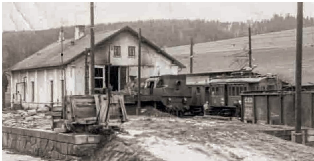
Původní depo a dílny, které se nacházeli v zastávce Vyšší Brod – klášter v místech, kde dnes stojí bývalá pila.
