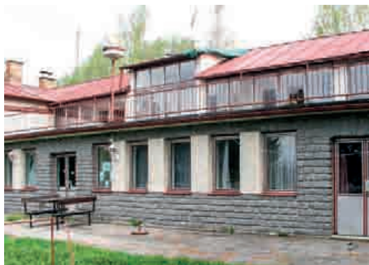
Původní podoba objektu.
