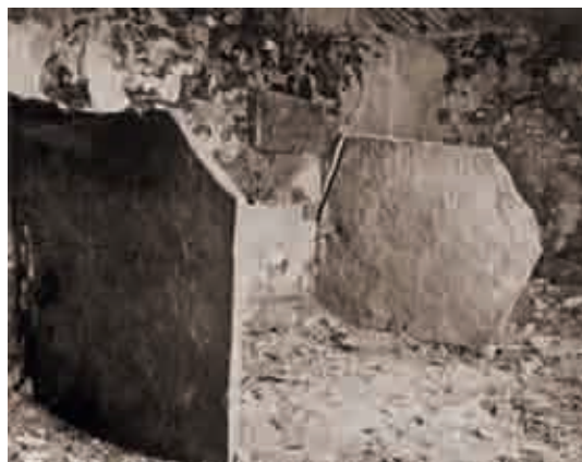
Ve stáji v Horní Borkové (Fleissheim) se v jednom z opuštěných domů uchovaly přepážky, umně štípané z kamene.
