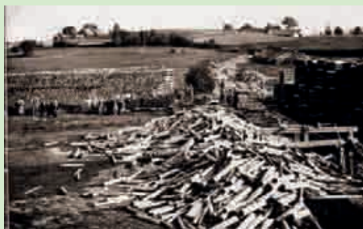
Ústí plavebního smyku do překladiště dřeva. V tomto místě bylo polenové dříví vytahováno z vody a rovnáno do hranic. (zdroj: Šumavské muzeum Pasov)
